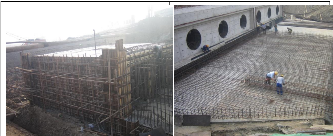
主体建筑物施工
