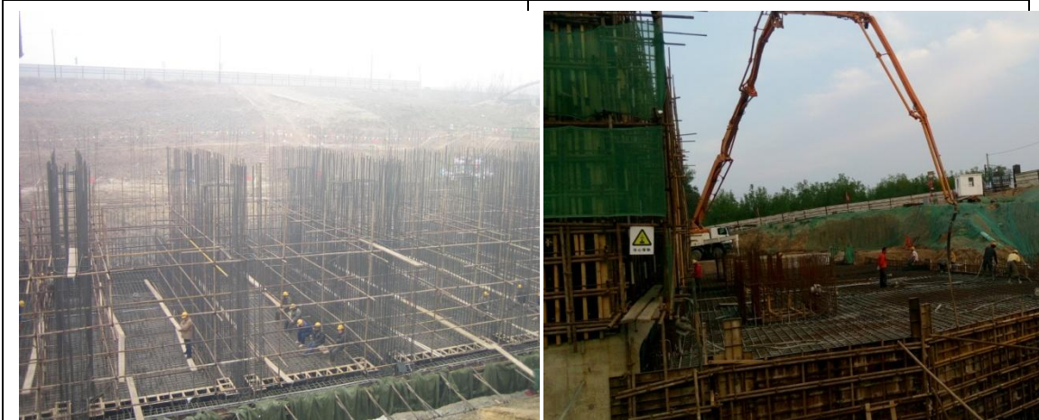
主体建筑物施工
