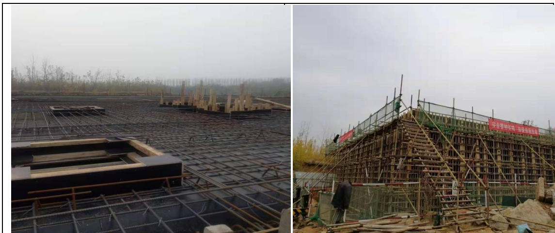
主体建筑物施工
