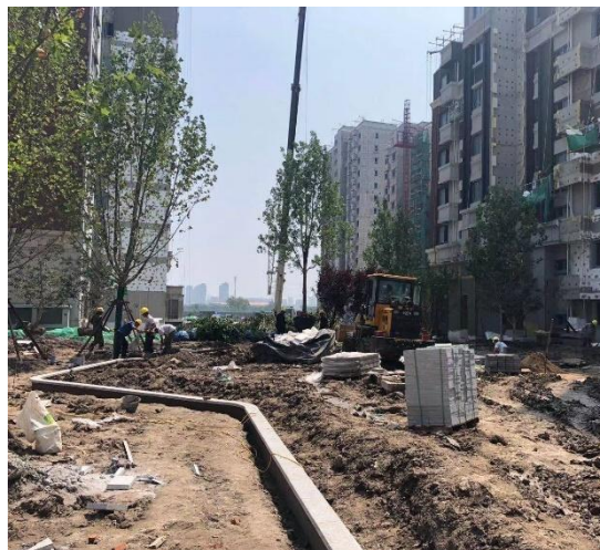
透水砖铺装及绿化施工
