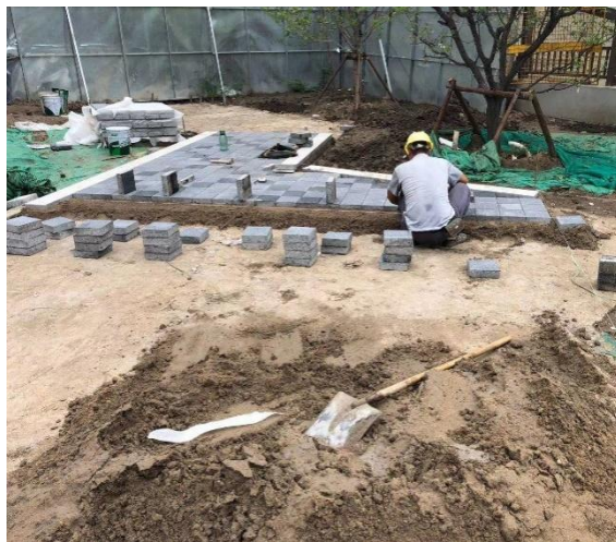
透水砖铺装及绿化施工
