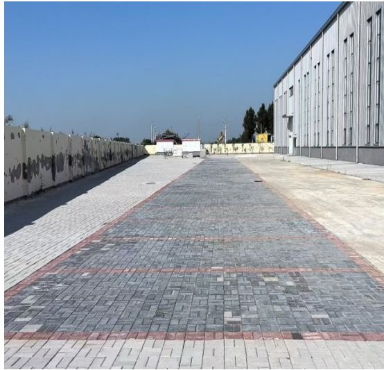
道路硬化及停车位透水铺装
