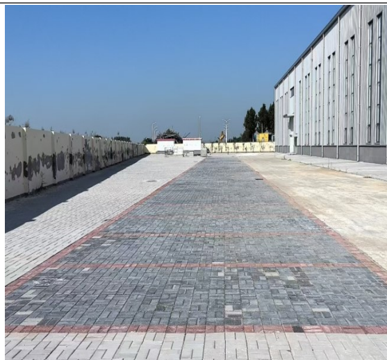
道路硬化及停车位透水铺装
