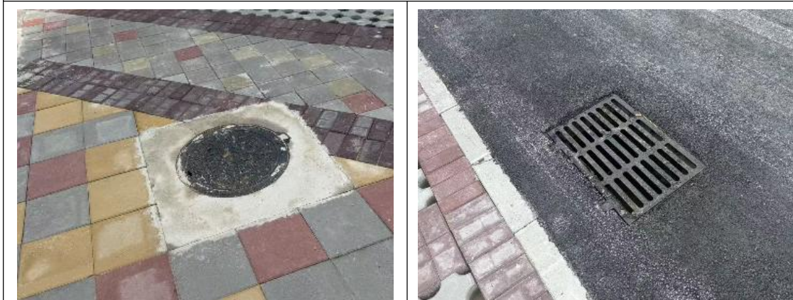
雨水排水工程、透水混凝土铺装现状照片
